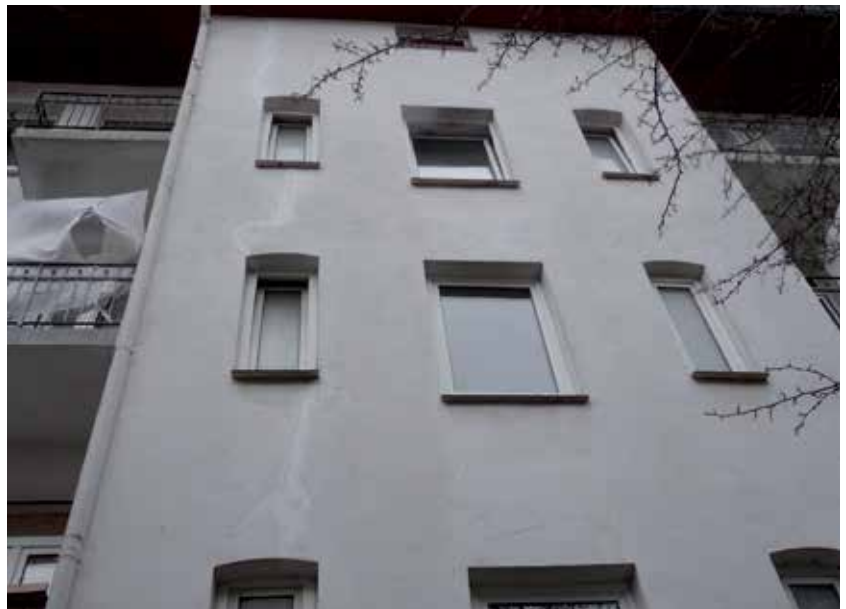
ABB. 2: Vorderansicht (oben) und Rückansicht (unten) des Mehrfamilienhauses.
